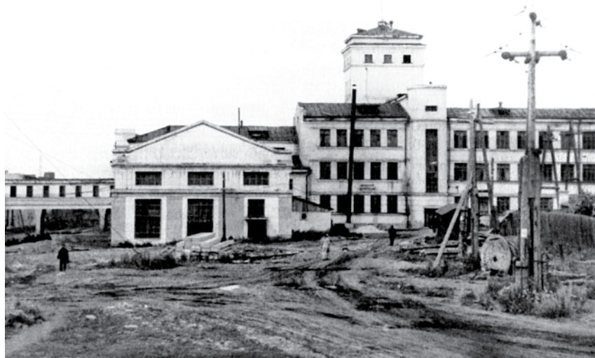
Административно-бытовой комбинат шахты «Северная» Кемеровского рудника
